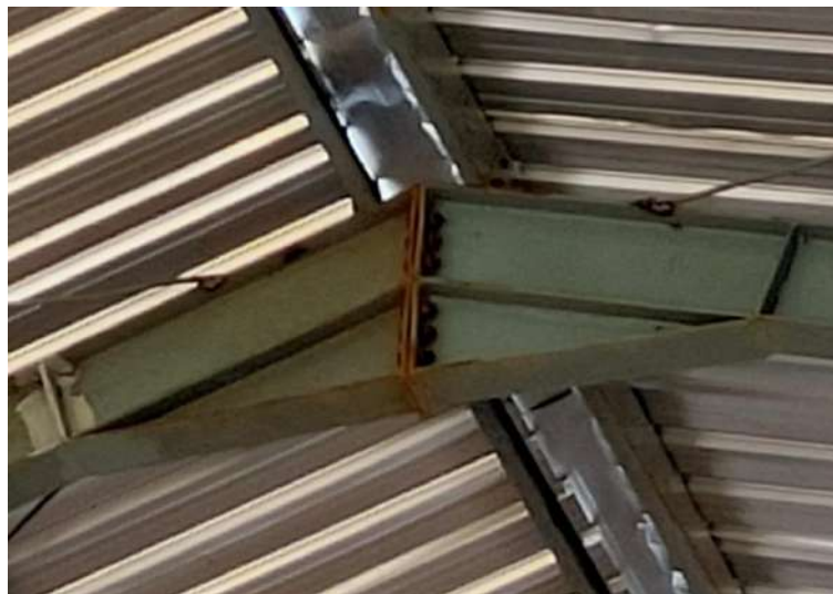
Gambar 4.52 Sambungan Baut Rafter ke Rafter
