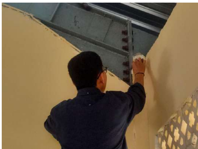
Gambar 4.50 Pengukuran Sambungan Baut Rafter ke Kolom
