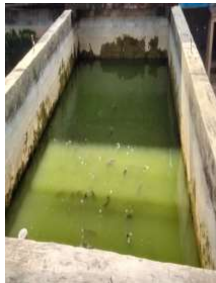
Gambar 7. Kolam lokasi 4 Salawati Sumber : Dokumentasi pribadi
