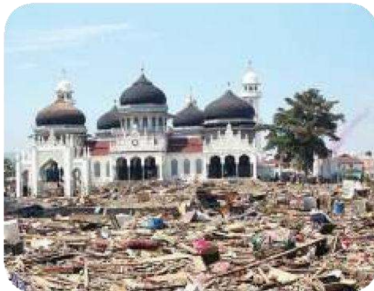
Gambar 2.15. Akibat gempa bumi di Aceh, 26 Desember 2004
