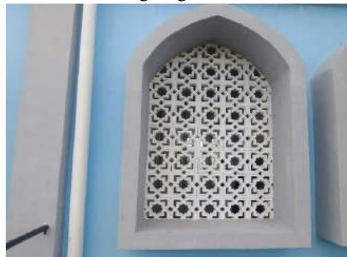
Observasi kondisi sirkulasi udara (Ventilasi)
