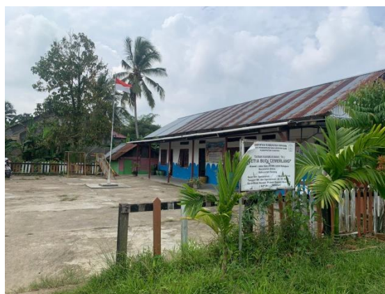
Gambar 4.3 Gedung TK Setia Budi Cemerlang Tampak Depan
