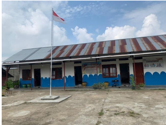
Gambar 4.4 Gedung TK Setia Budi Cemerlang Tampak Samping
